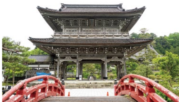
▲圧倒的な存在感。高さ17.4m×間口20m×奥行14.4mの山門はほぼ健在
