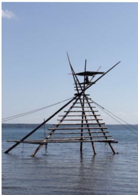
▲丸太を組み上げて高さ7～8mに
