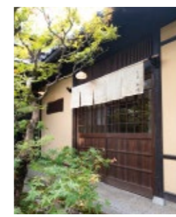
蔵を改装した風情ある建物
