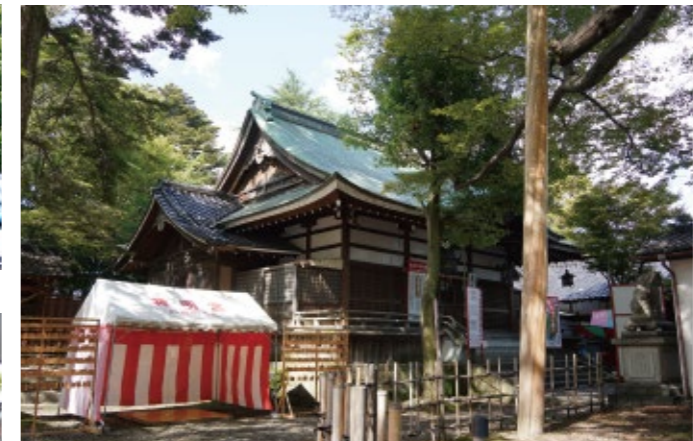
背の高い木々に囲まれて拝殿、本殿が鎮座
