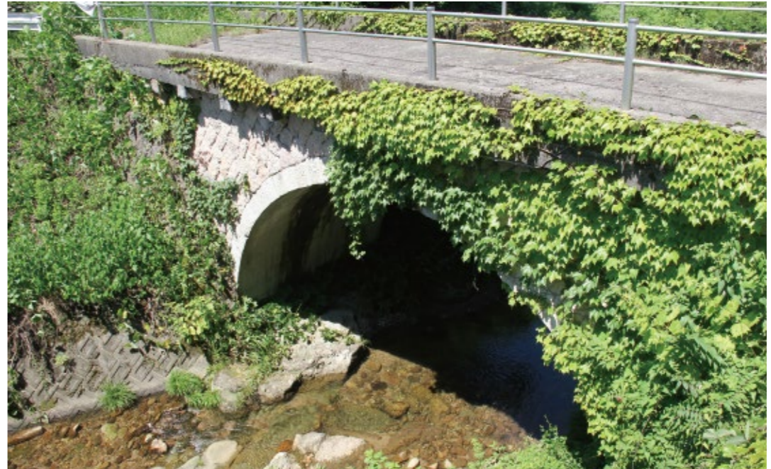
滝ヶ原のアーチ型石橋、丸竹橋は車も走る生活道路
