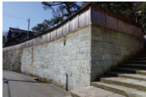
笏谷石を積み上げた石垣が残る屋敷
