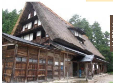
「国指定重要文化財 岩瀬家」。五箇山最大の規模を誇る合掌造りを公開。〒南砺市西赤尾町857-1
